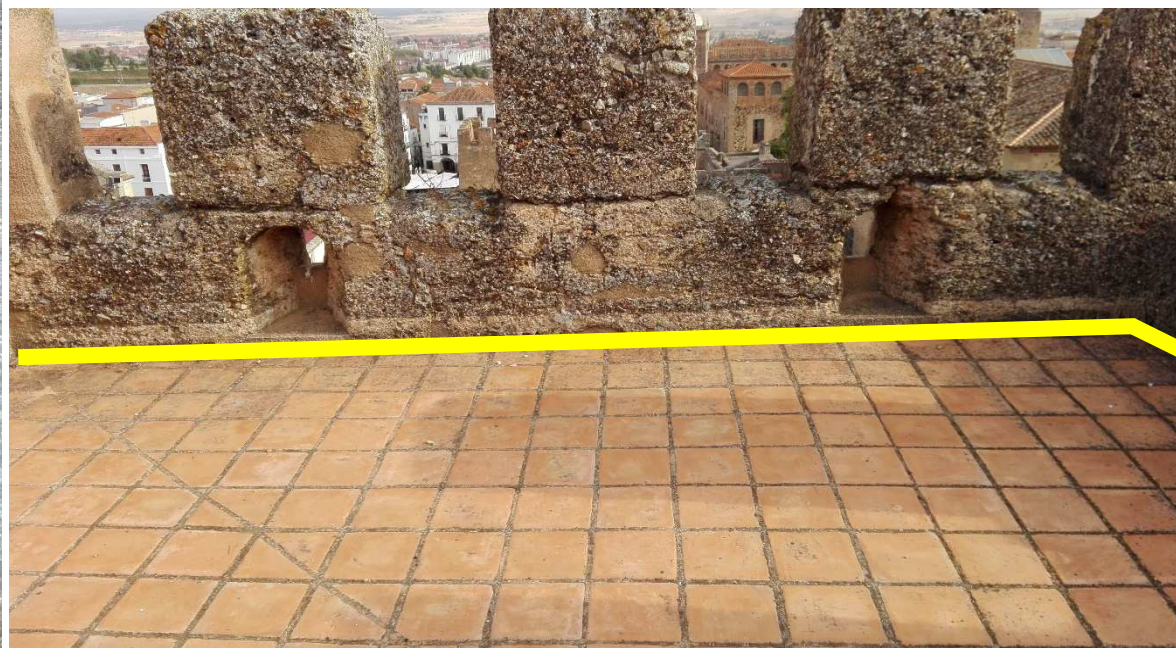
DETALLE DE TERRAZA DE LA TORRE
