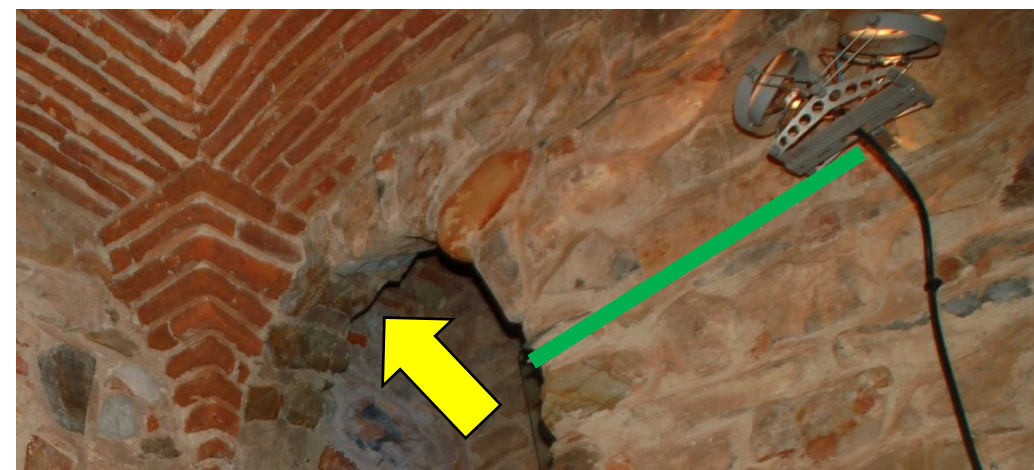
DETALLE DE LA CÁMARA TORRE BUJACO
