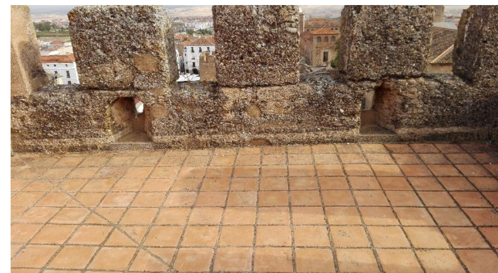
VISTA LATERAL DE LA TERRAZA DE LA TORRE
