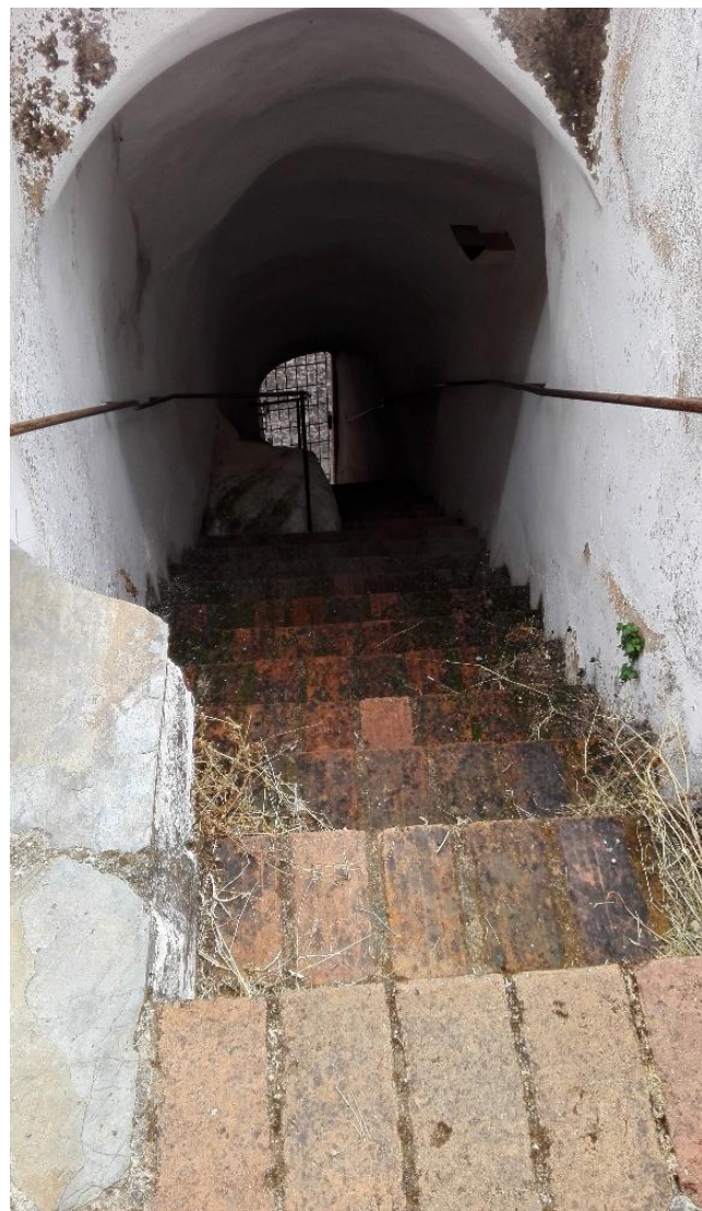
VISTA DESDE ARRIBA DE LAS ESCALERAS DE ENTRADA A LA TORRE
