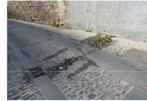
ENCUENTRO DE INMUEBLE Y MURO DEL PATIO ELEVADO
