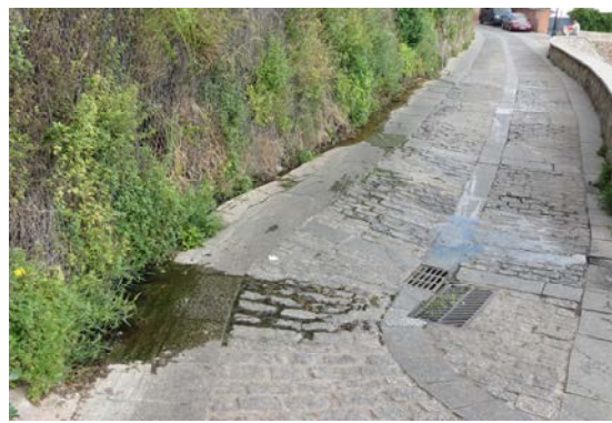
VISTA GENERAL ASCENDENTE, DESDE CISTERNA HACIA EL TRAMO DEL JARDÍN - SENTIDO CALEROS
