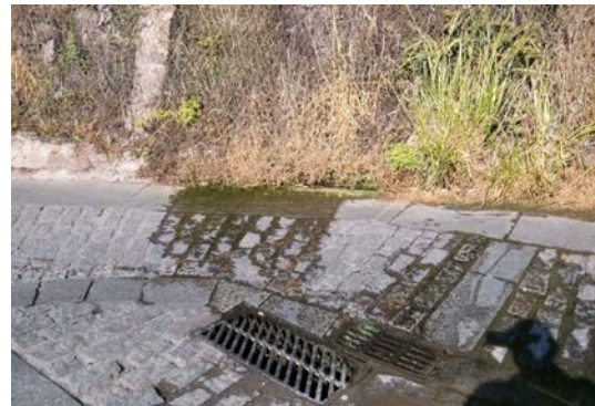
SUMIDERO FINAL INFERIOR DE SAN ROQUE, JUNTO A LA CISTERNA Y MIRALRIO
