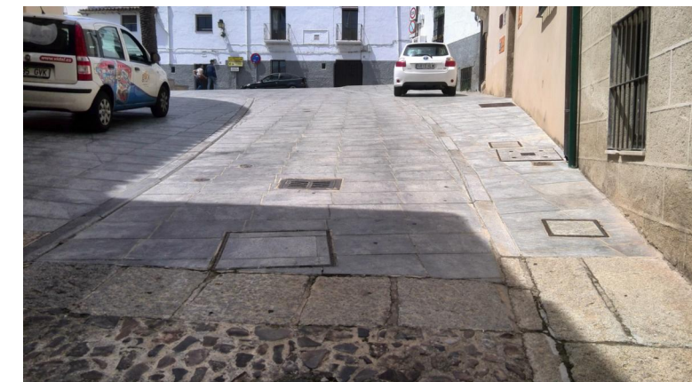
5. DETALLE PAVIMENTO EN CALLE TORREMOCHADA
